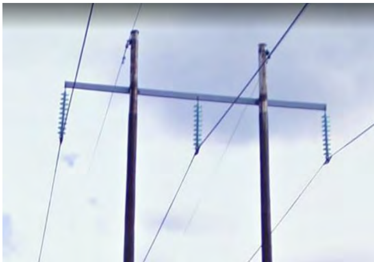
Figur 4. Exempel på en luftledning med träportalstolpar sträckan Bergforsen-Söråker.
